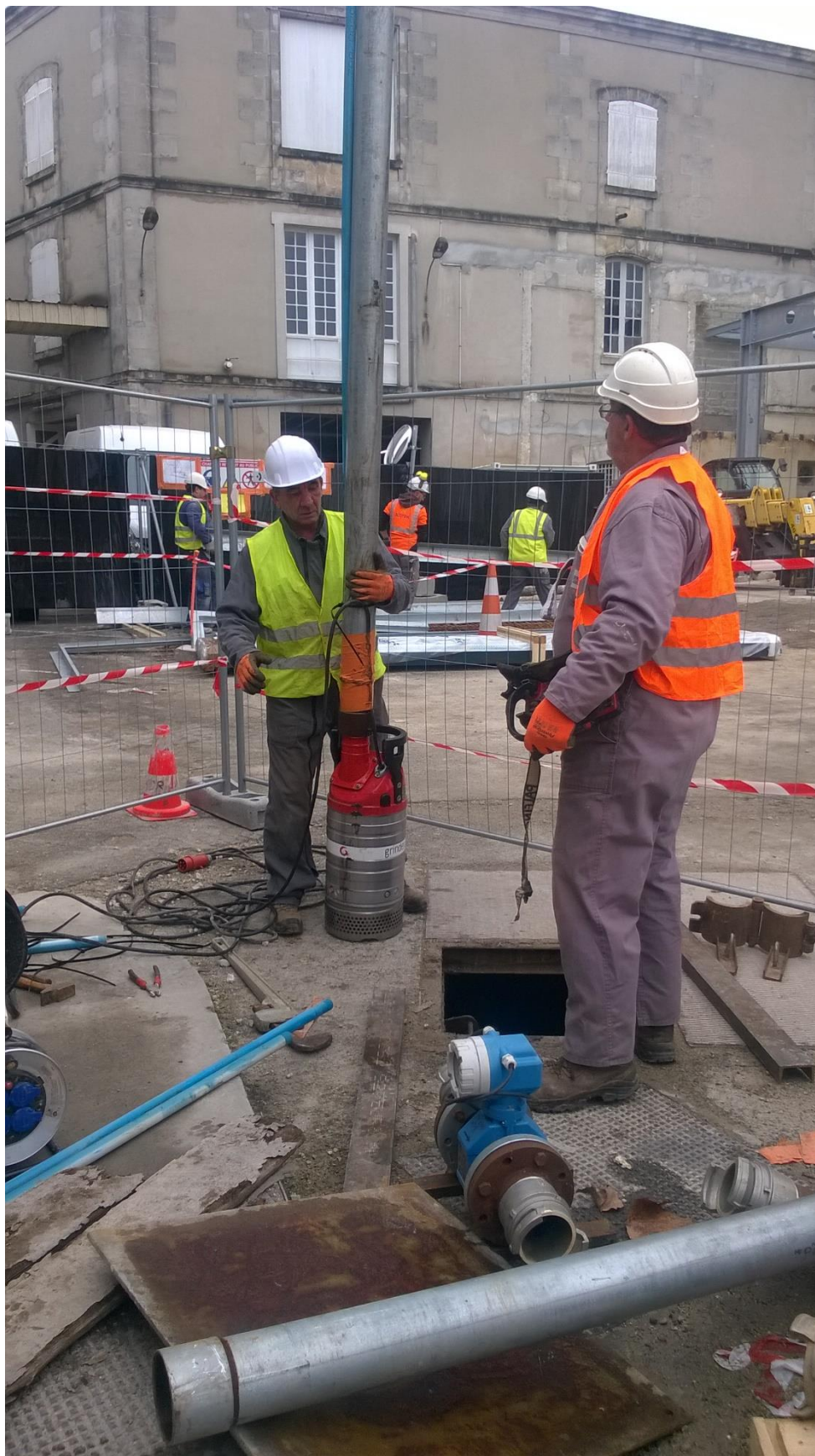
Figure 10 – Installation de la pompe dans le puits en grand diamètre
