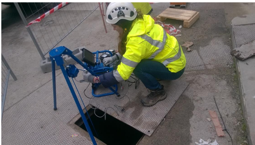
Figure 11 – Inspection caméra du puits en grand diamètre
