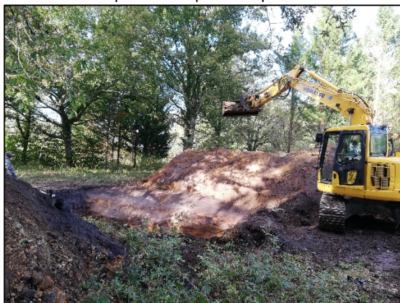
Fouille à la pelle réalisée le jour des investigations au droit de la zone d'implantation pressentie
