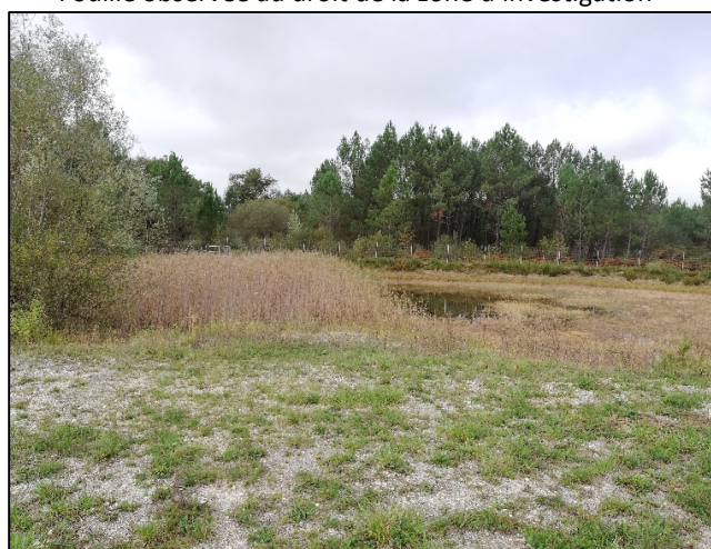
Bassin de rétention observé au sud-ouest du site (en eau)
