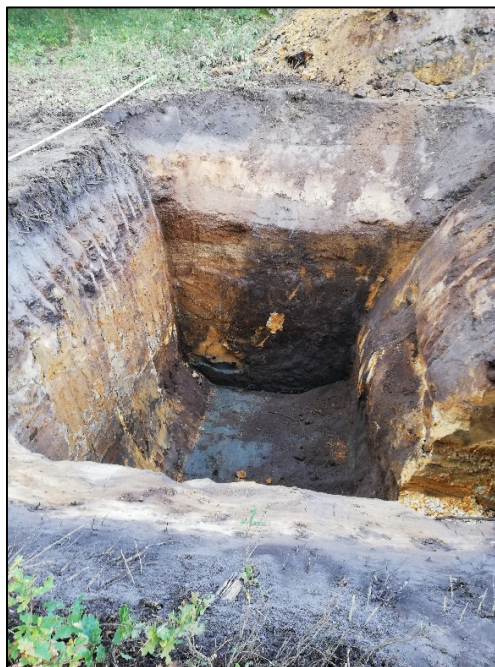
Fouille observée au droit de la zone d'investigation
