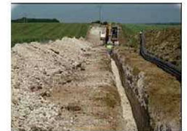
Figure 4 : Réalisation de la tranchée puis déroulage des fourreaux PEHD le long de la fouille avant de les descendre
