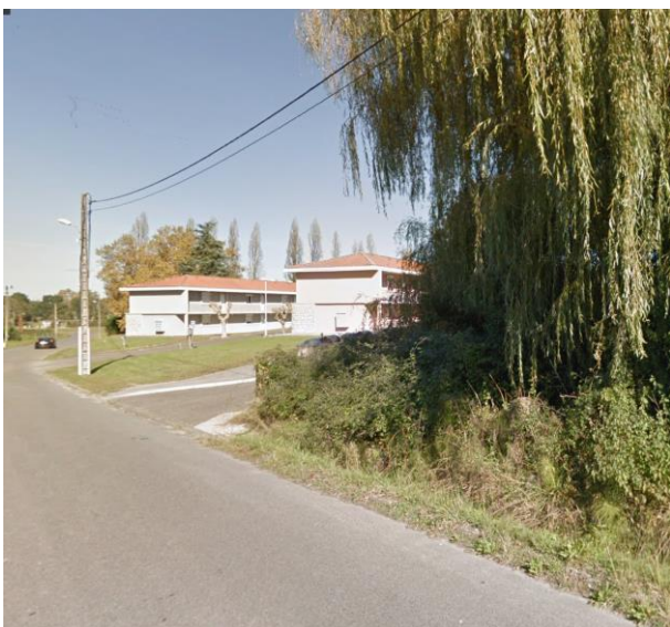
Illustration 23 : Entrée vue Sud (source : Google Street View)
