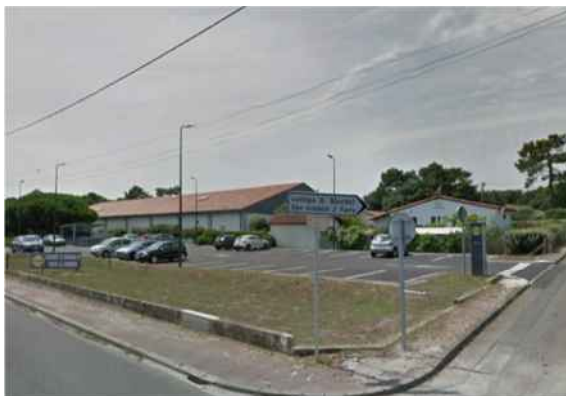
Vue du parking existant – Parcelle 137 (7)
