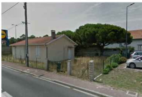
Vue de la maison d'habitation – Parcelles 146 à 148 (9)
