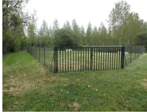
Environnement immédiat du captage de la Fontaine de Maillé
