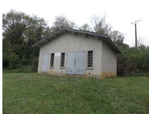
Station de pompage de la Fontaine de Maillé
