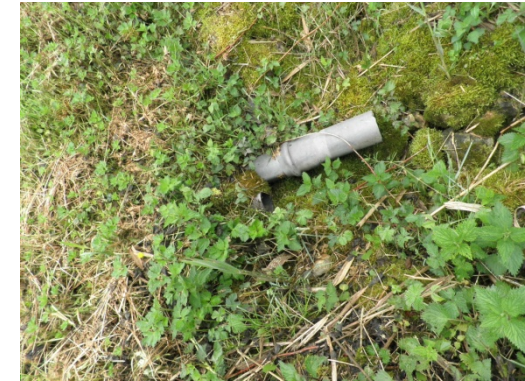
Canalisation située à l'ouest du captage de la Fontaine de Maillé
