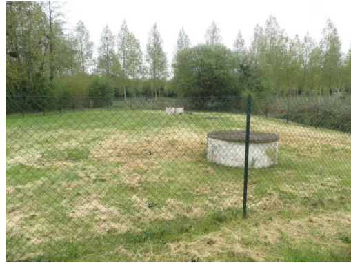
Environnement immédiat du captage de la Fontaine de Maillé
