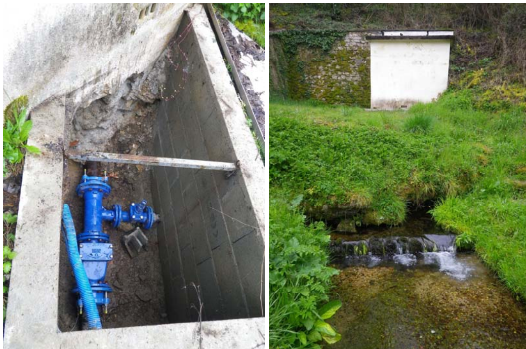
Figure 4 : exutoire de la source (photos)
