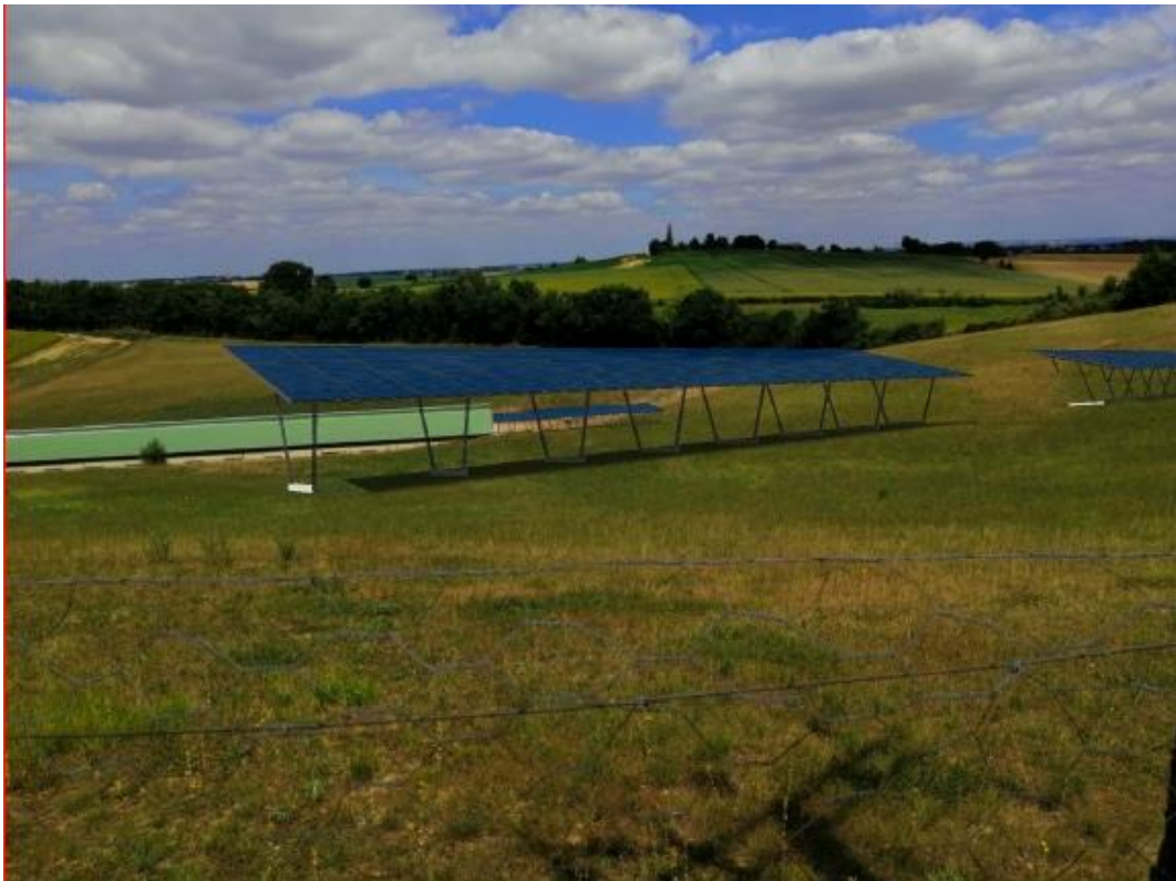
Figure 10 : Ombrière photovoltaïque pour parcours de volailles plein air (doc Novafrance Energy)
