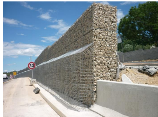
Ecran en gabions
