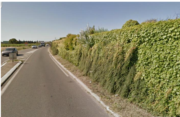
Ecran végétalisé avec mur béton
