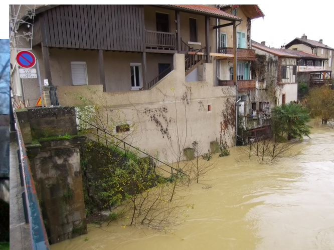
Crue de Janvier 2013
