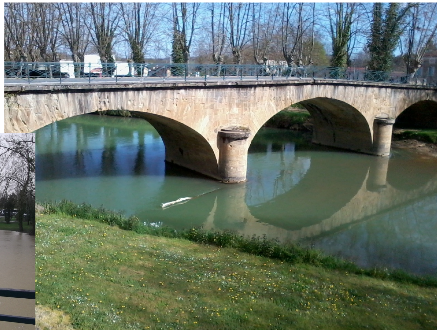
Vue du pont de la station de Plaisance
