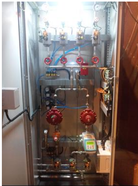
Armoire d'injection pour une ligne
