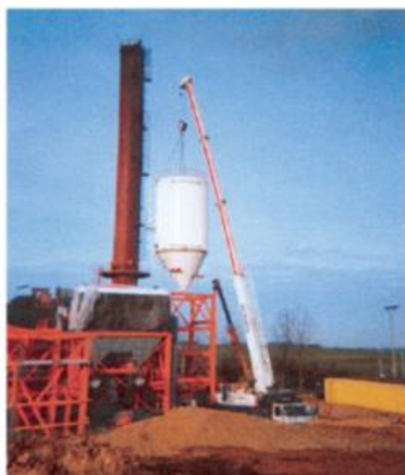
Pose du silo à REFION
