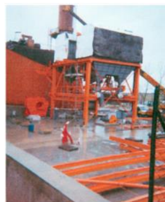
Montage du filtre à manche
