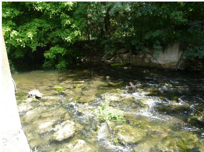
Figure 20 : Rampe d'enrochement à l'emplacement du clapet sur l'Antenne
