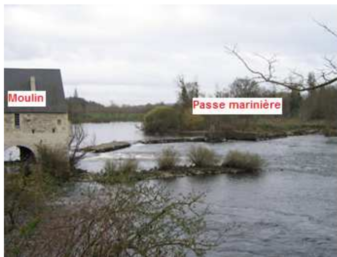
Figure 11 : Vue générale du site de Chitré avant l'intervention, source : http://www.bief.net
