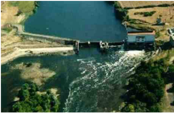
Figure 8 : Barrage de Maison-Rouge avant son effacement (source : ONEMA)
