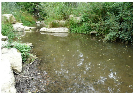
Figure 10 : Effacement de la pelle et aménagements aux abords
