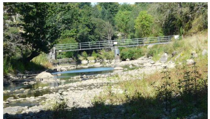
Figure 19 : Clapet abaissé sur le Thouet à Parthenay
