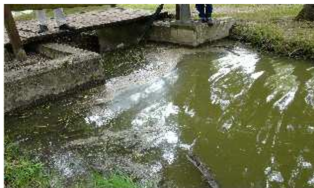
Figure 2 : Effet plan d'eau à l'amont d'un ouvrage sur un affluent du Clain
