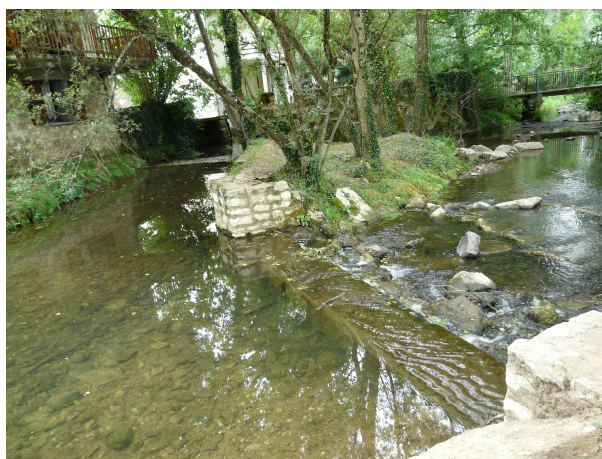
Figure 17 : Bief sur la gauche et bras de contournement aménagé en rive droite
