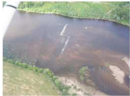
Figure 9 : Barrage de Maison-Rouge en 2006, après son effacement (source : LOGRAMI)
