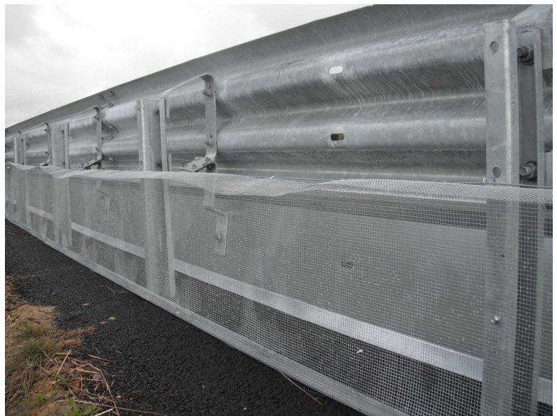
Exemple de clôture posée sur glissière
