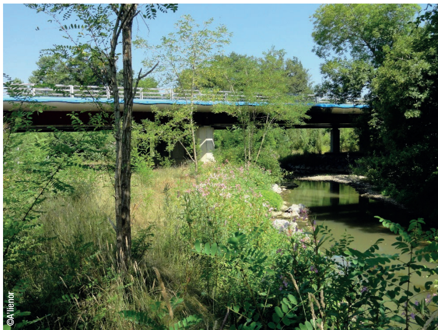
Viaduc sur l'A65 - Exemple d'ouvrage de transparence écologique
