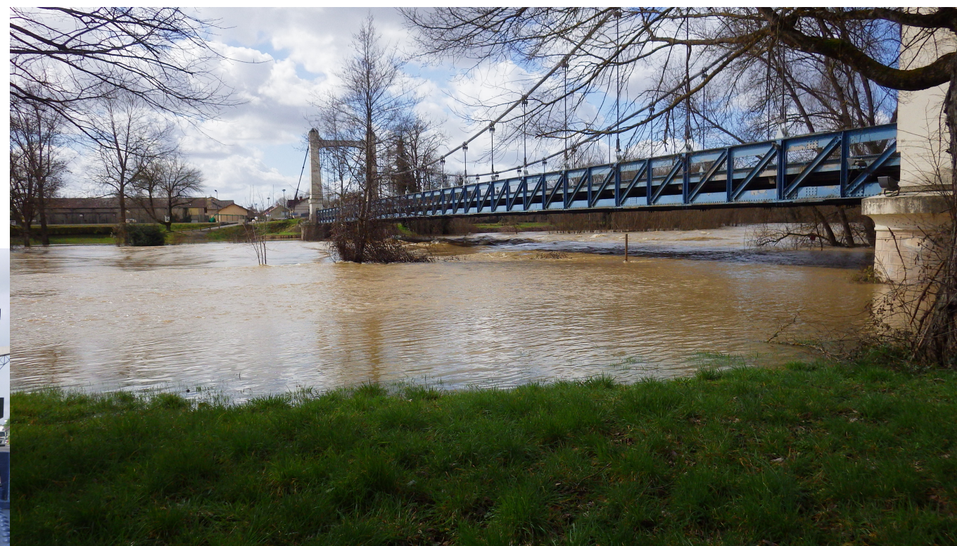
Vue du pont de la station de Riscle
