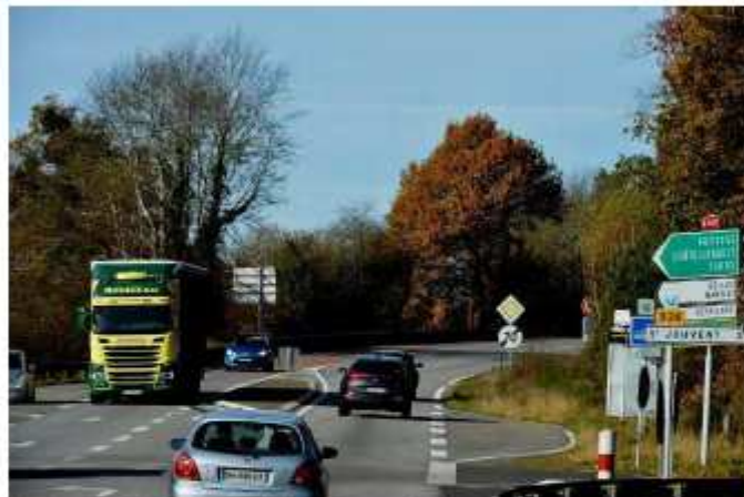
Les riverains ont fini d'exprimer leurs idées et craintes pour l'aménagement d'un créneau de dépassement entre Limoges et Bellac. De nombreuses questions ont été soulevées, © stephane Lefevre
