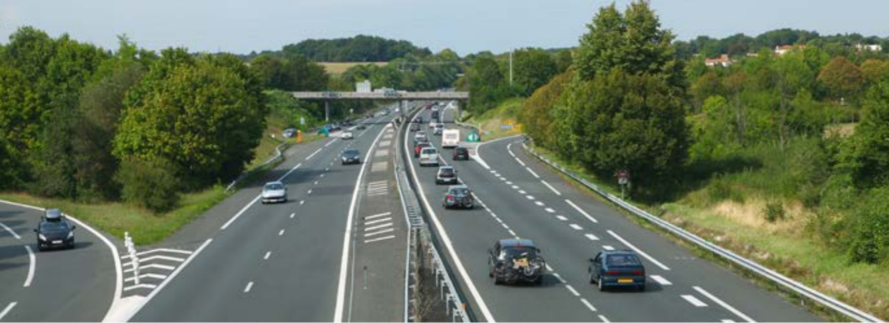
Exemple de route express avec échangeurs dénivelés
