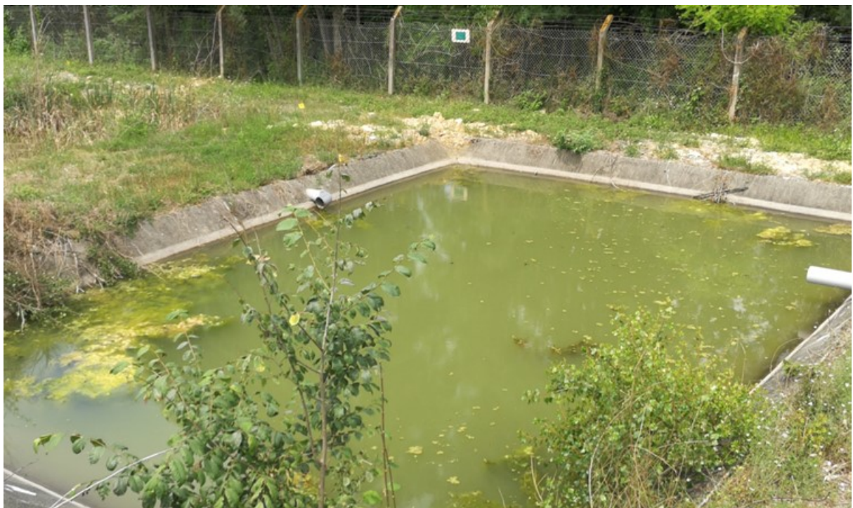
photo.5: vue d'un bourbier ouest à fond bétonné.
