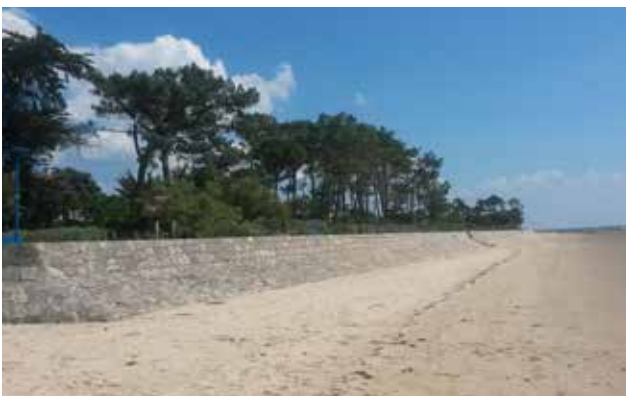
Illustration 35 : Couronnement de perré - Andernos-les-Bains
