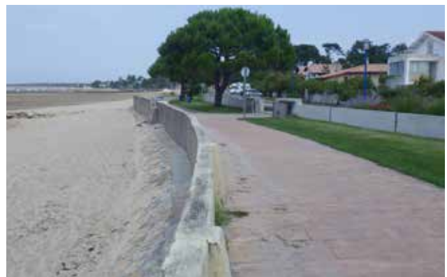
Illustration 36 : Muret de protection - Andernos-les-Bains
