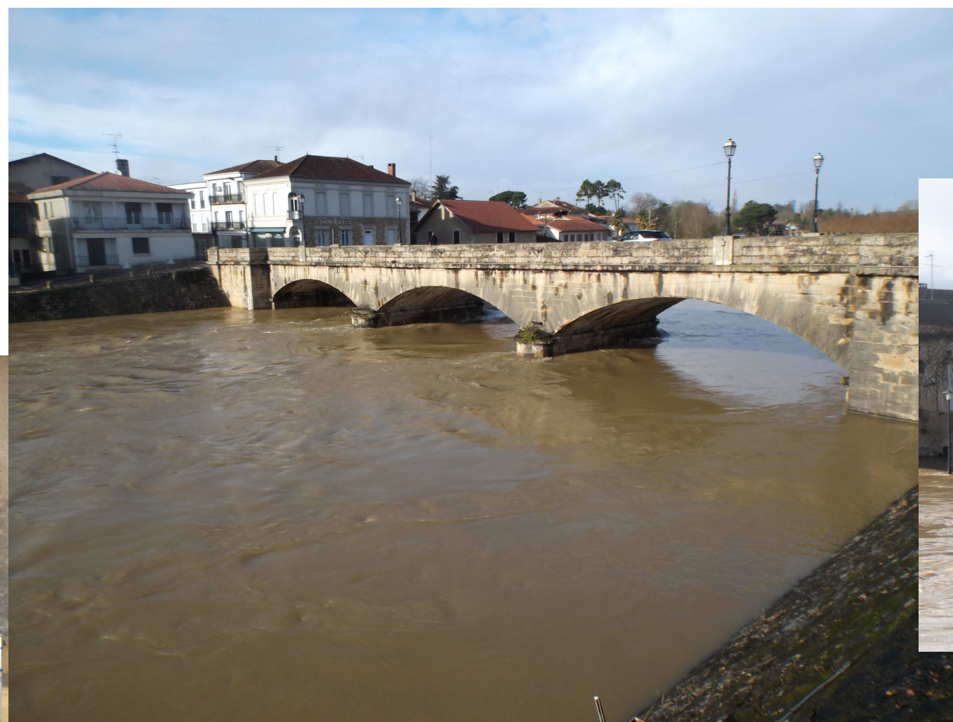
Janvier 2014 : Vue du pont de la station de Tartas
