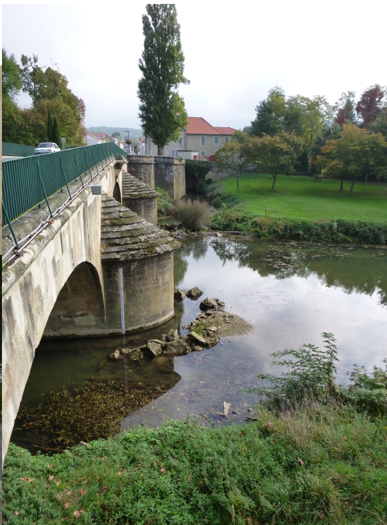
Vue du pont de la station de Villecomtal
