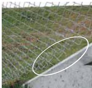
Défaut de raccordement à l'ouvrage hydraulique
