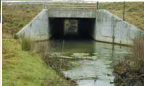
☑ Cas n°2 : Le projet n'a pas prévu de possibilité de franchissement pour le Vison : aucune berge n'est aménagée dans les ouvrages, seule la fonction hydraulique est assurée.
