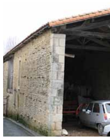
Moellons non enduits sur dépendance
