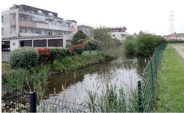
Bassin de rétention (Artelia, 2022)
