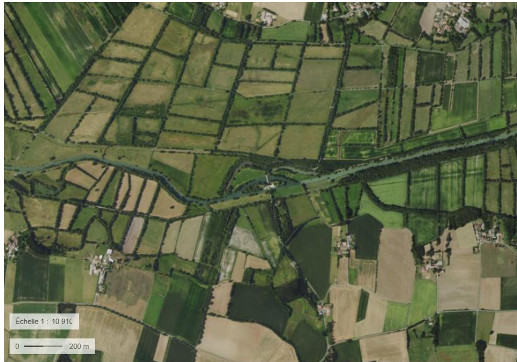
Figure 28 : la maison éclusière de Bel Ebat et les espaces naturels proches
