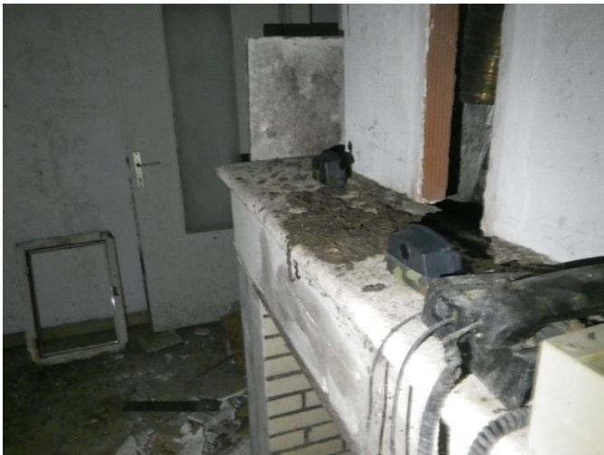
Photo. 3 : vue du Batlogger au point pièce RDC1 (SCE, 25/09/2023)
