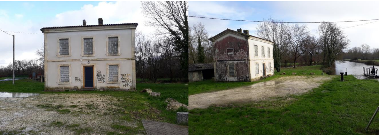
Figure 3 : Vues de la maison éclusière
