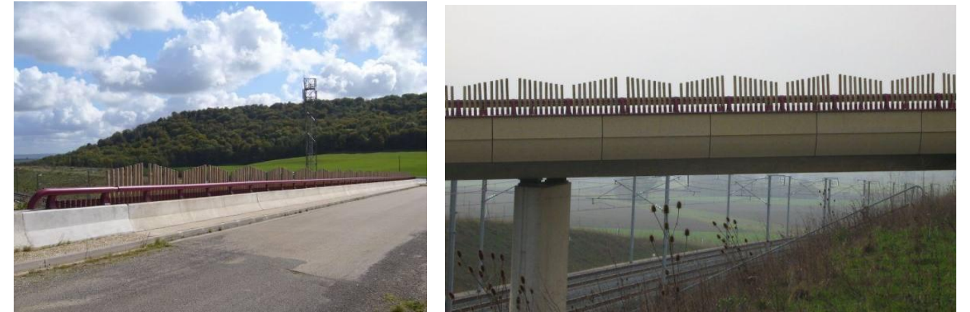
Figure 65 : Exemple de haies de poteaux installées sur un pont route pour le guidage des chiroptères
