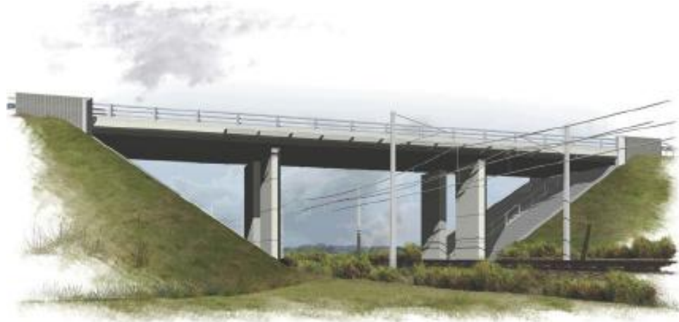
Figure 25 - Pont-route à tablier à dalle à trois travées (Source : SNCF/ARCADIS - Dossier de consultation, 2006)
