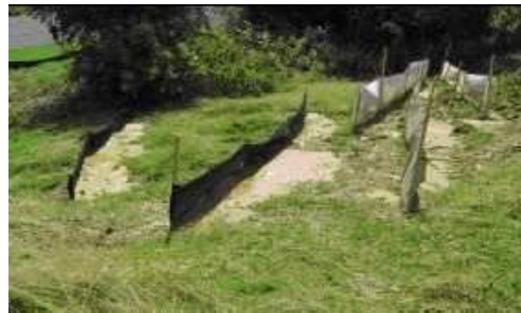
Barrages filtrants en géotextile
