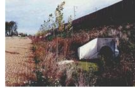
Figure 12 - Ouvrage de traversée hydraulique
