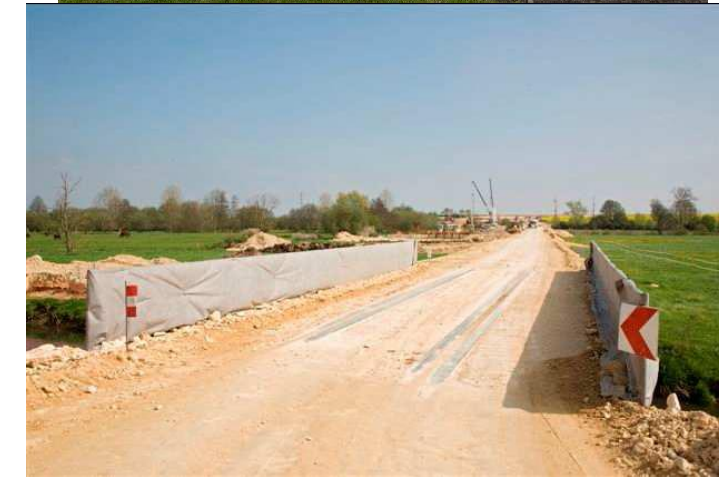
Figure 57 – Exemples de franchissement par pont provisoire (A88)
