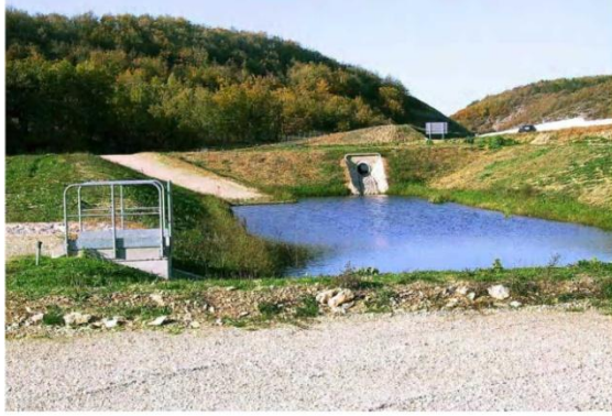
Figure 13 - Exemple de bassin de traitement
