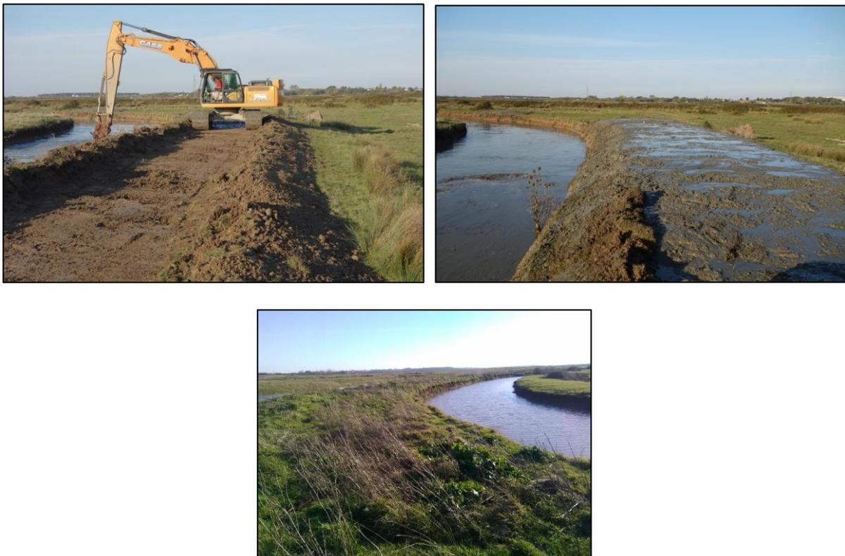
Figure 54 : Réalisation d'un merlon avant dépôt des vases et résultat deux ans après (photo centrale)
