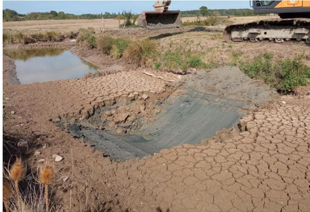
Figure 57 : Mise en œuvre de pentes douces sur banquettes dans des secteurs en assec
