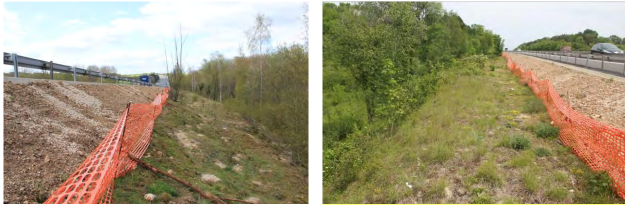
Mise en défens à l'aide de filet de protection sur un chantier autoroutier (A11, Cofiroute) –
