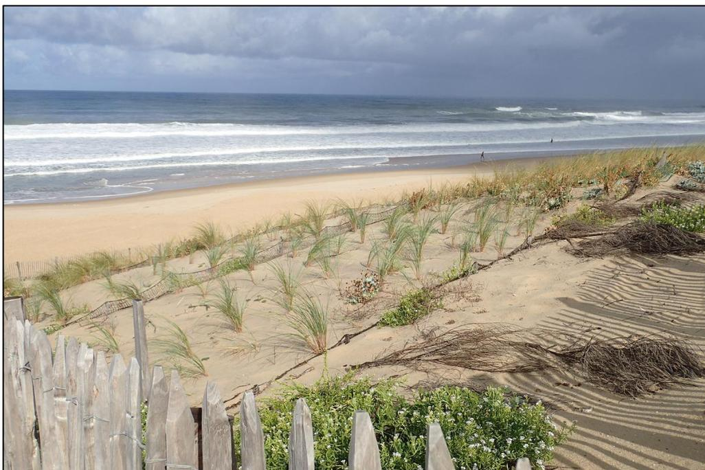
**Illustration d’exemple du dispositif traditionnel avec plantation d’oyats en quinconce, couvertures de branchages de genêts et délimitation par des ganivelles**
