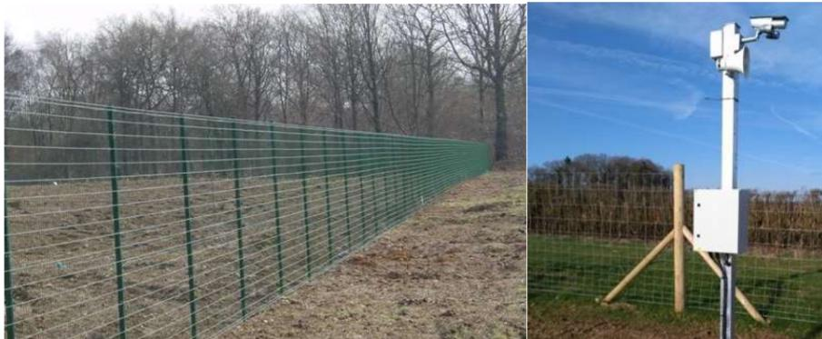
Un système d'alarme anti-intrusion est installé sur l'ensemble de la clôture. Ce système est en mesure de détecter une rupture dans la clôture et d'envoyer un signal d'alerte à un centre de sécurité.
