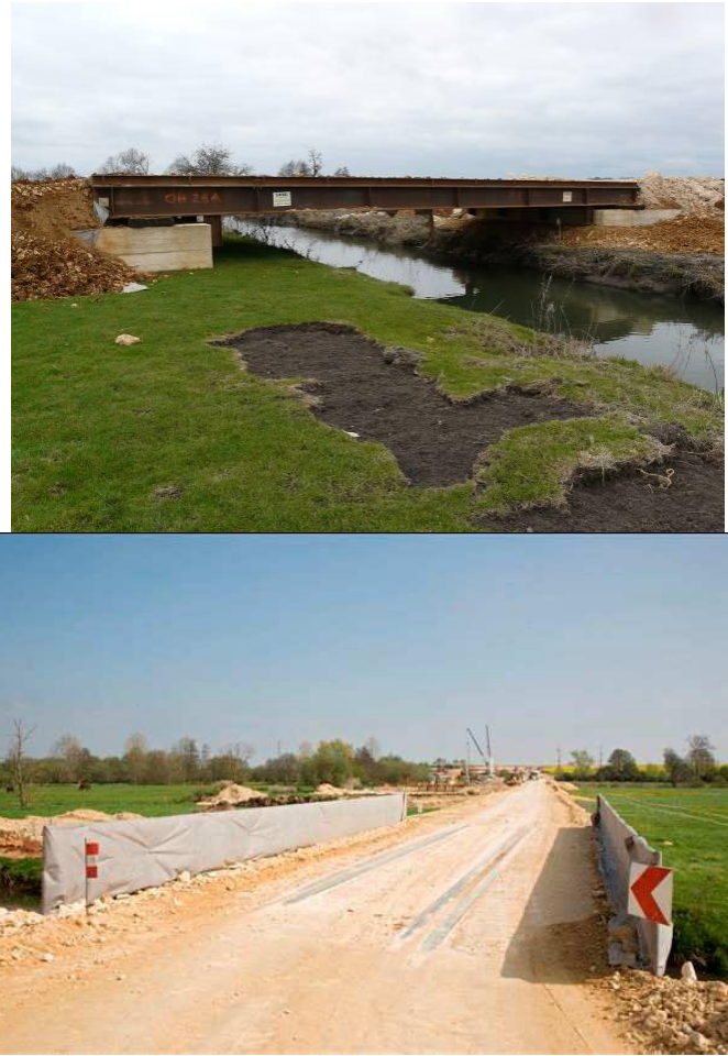
Figure 58 – Exemples de franchissement par pont provisoire (A88)
