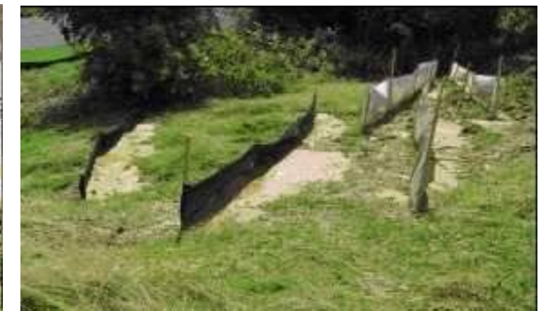
Barrages filtrants en géotextile
