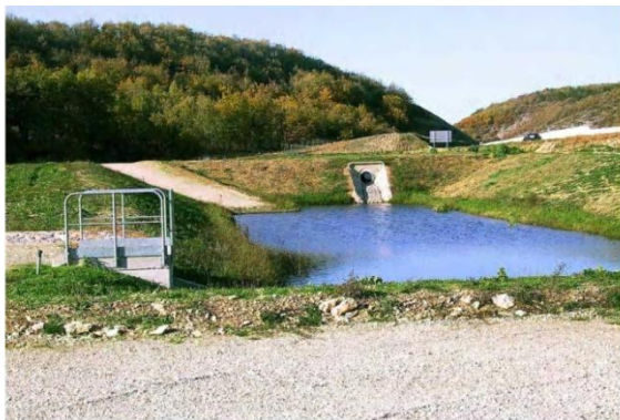
Figure 13 - Exemple de bassin de traitement
