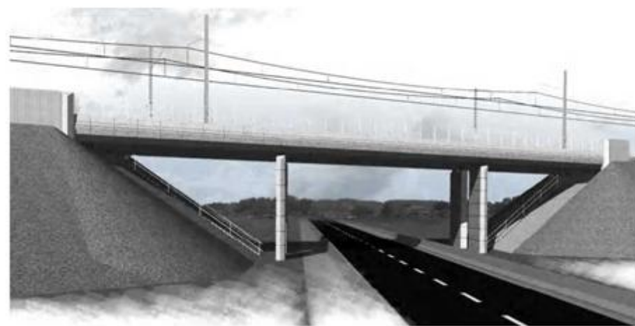
Figure 25 - Pont-route à tablier à dalle à trois travées (Source : SNCF/ARCADIS - Dossier de consultation, 2006)
