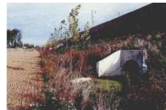
Figure 12 - Ouvrage de traversée hydraulique
