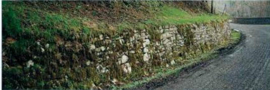
◀ Murs de soutènements en pierres recouverts de mousse et murets garde-corps avec dalles de couronnement en pierres
