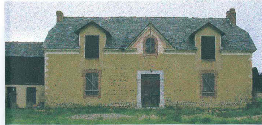
MAISON A SERON ( 65 ) . Encadrement de pierre d'Arudy pour la porte et briques pleines . 1901 .
