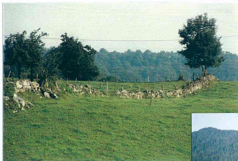
▲ muret de pierres sèches peu entretenu
