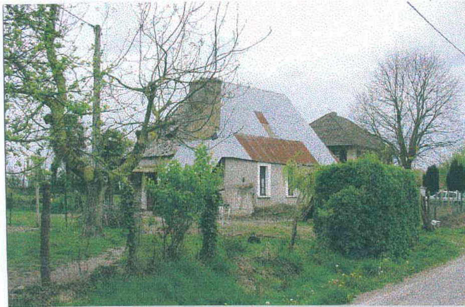
MAISON A LOMBIA . La tôle a remplacé le chaume.
