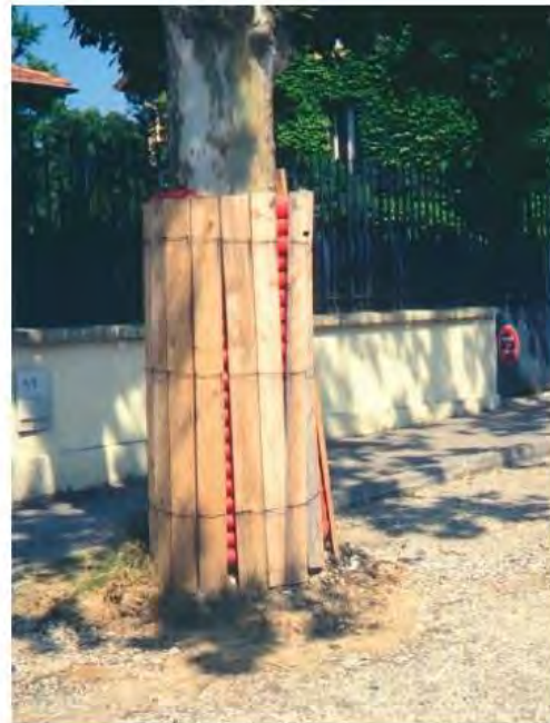
Figure 11 : Technique de protection temporaire du tronc
