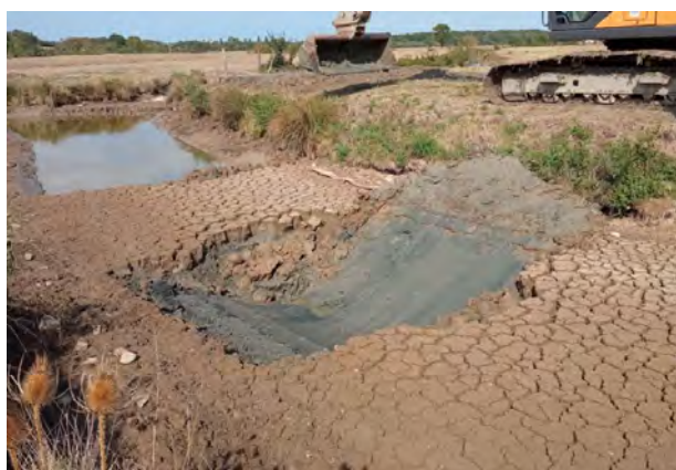
Figure 53 : Mise en œuvre de pentes douces sur banquettes dans des secteurs en assec
