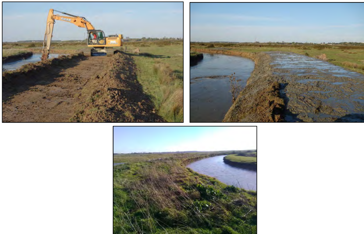
Figure 50 : Réalisation d'un merlon avant dépôt des vases et résultat deux ans après (photo centrale)
