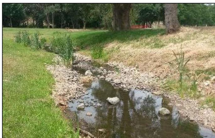
*Photo 1 : Exemple de blocs dispersés sur recharge granulométrique*
