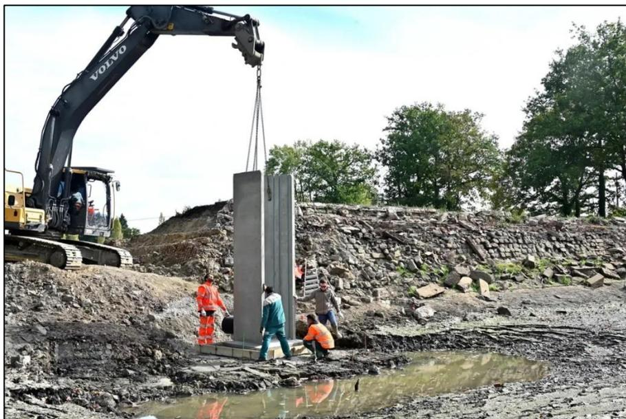
*Figure 12 Exemple d'installation d'un moine de vidange*
