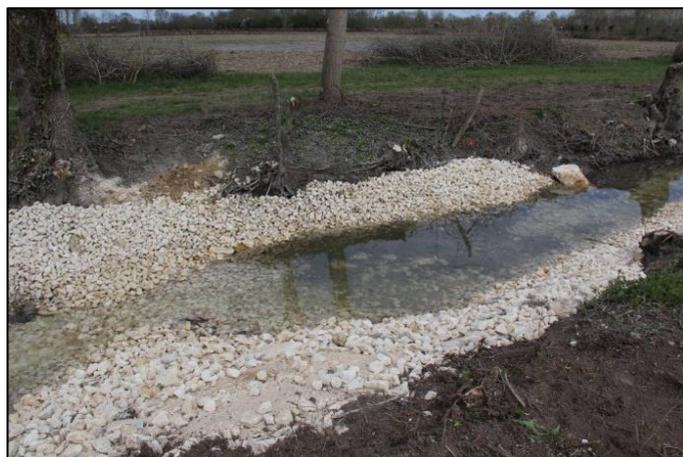
*Figure 23 Exemple de "seuil-radier"*
