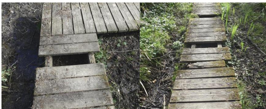
*Figure 32 Dégradations constatées sur les aménagements existants*
