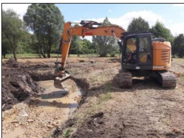
*Figure 28 Exemple d'alternance fosse / radier après recharge granulométrique*
