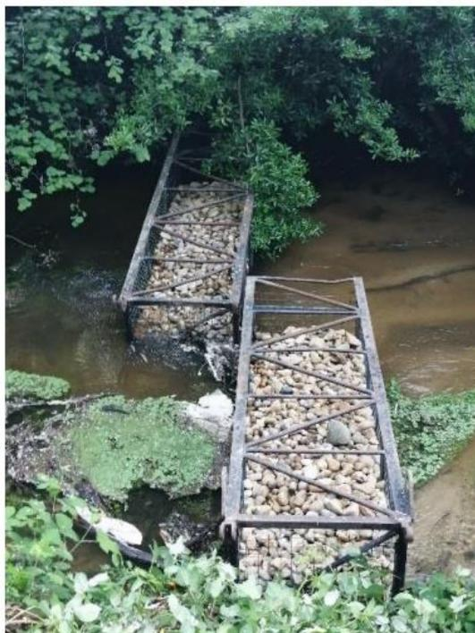
*Figure 10 Exemple de cages métalliques remplies de pouzzolane*
