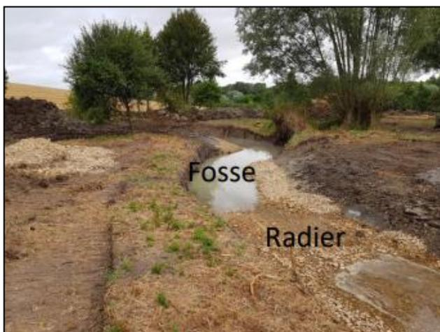
*Figure 29 Exemple d'alternance fosse / radier après recharge granulométrique*
