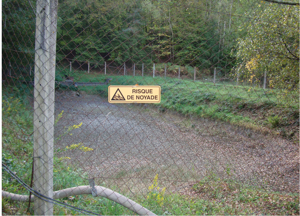
Annexe 1 : bassin de la station de traitement des eaux clôturé
