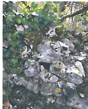
Le muret séparatif entre le site et les rue des Augustins et des Côteaux de Bel Air est constitué de divers matériaux : moellons de pierre, enduits, pierres maçonnées. L'enceinte est surmontée d'une clôture en fer forgé.
