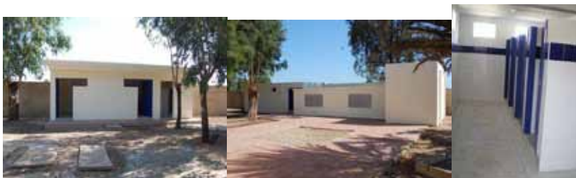
L'état des bâtiments après les travaux.
