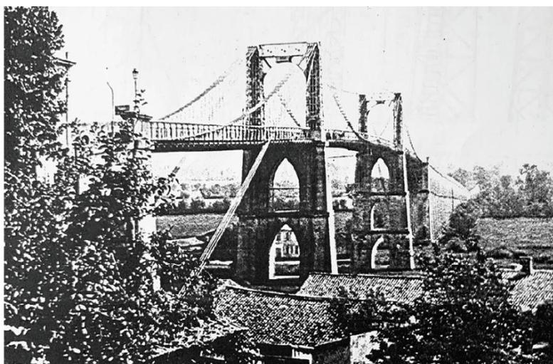
1934-1935 - Début du chantier de consolidation du tablier du pont par FIVES-LILLES. Changement des pylônes en cours, les portiques sont encore ceux mis en place par ARNODIN en 1885
