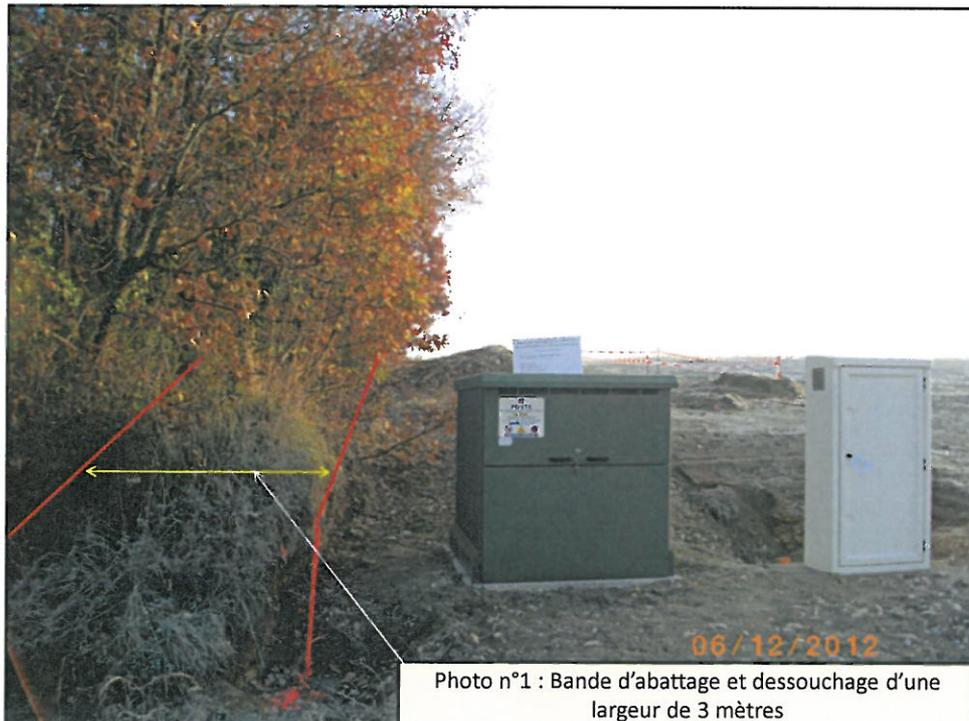
Photo n°1 : Bande d'abattage et dessouchage d'une largeur de 3 mètres
