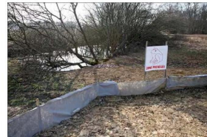
Figure 34 : Clôture anti-intrusion
