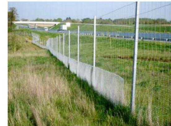
Figure 35 : Clôture doublée d'une clôture anti-intrusion amphibiens
