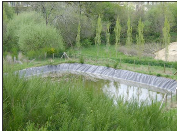
Bassin d'orage du SYMA au Nord de l'emprise du projet (crédit photo : erea-conseil)
