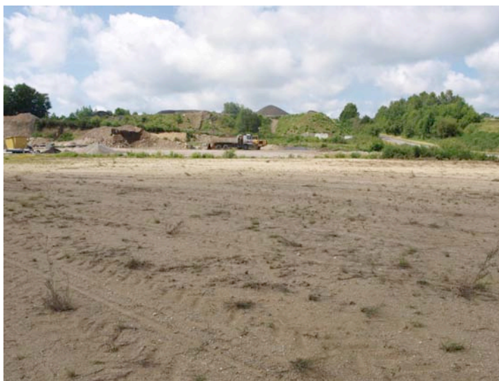
Plateforme du projet
