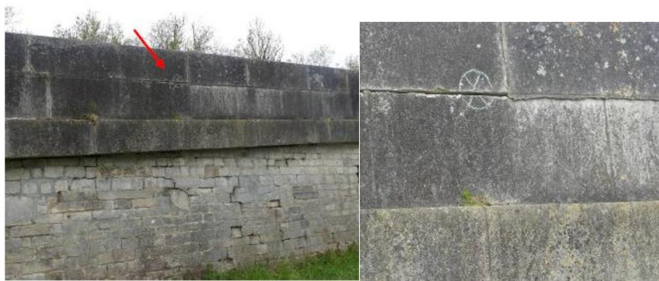
Figure 34. Disjointement sur la façade de la rampe en rive gauche, accueillant une Pipistrelle commune
