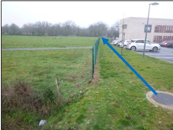
Busage des eaux pluviales vers l'ouest
