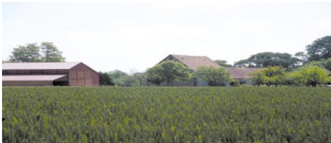
Hangar agricole en briques et toit de tôle rouge : une parfaite intégration paysagère
