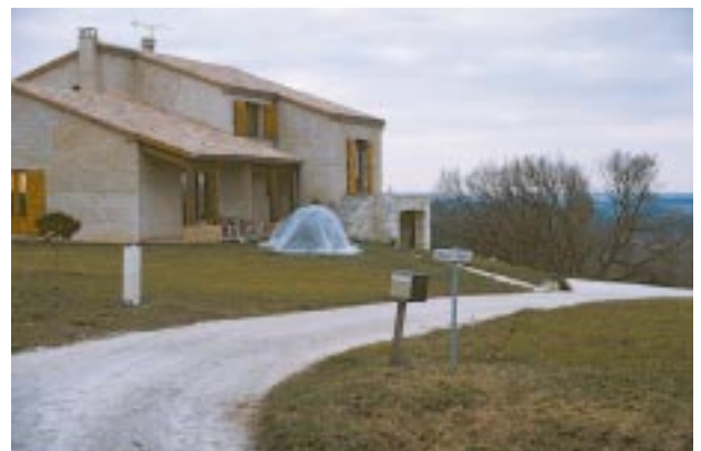
maison en construction à Born (vallée du Dropt)
