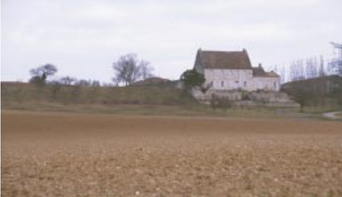
Habitat de pierre calcaire et toit de tuiles plates (Sauvetat-du-Dropt)
