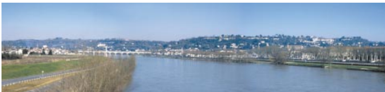
La ville d'Agen, à droite, peu visible, calée entre le coteau de la vallée et la Garonne
