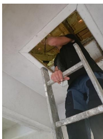
La trappe d'accès aux combles.
