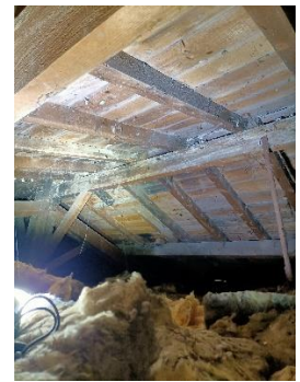
Vue des combles Est.
