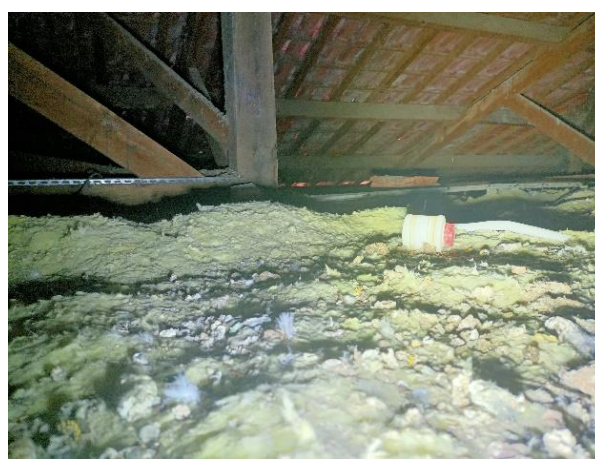
Vue des combles.
