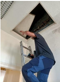
La trappe Ouest d'accès aux combles.
