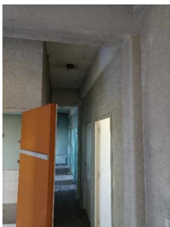
L'intérieur du bâtiment 1.
