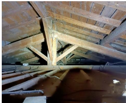
Vue des combles Ouest.
