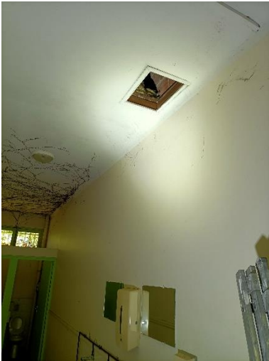
La trappe d'accès aux combles.
