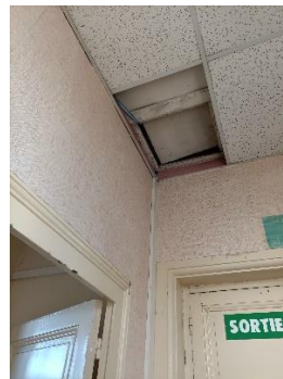
La trappe Est d'accès aux combles.
