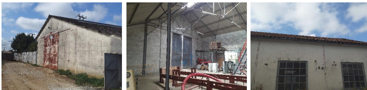
Figure 1 : Vues extérieures et intérieures du bâtiment concerné par la démolition (photos sur site, Biotope).
