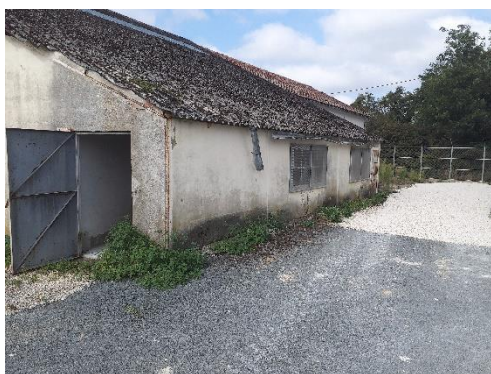
Vue extérieure du bâtiment (Biotope)
