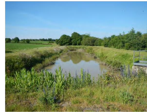
Bassin d'orage existant au sud de la RN 149
