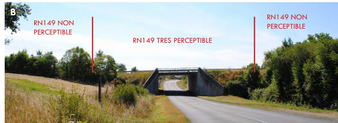
FENETRE VISUELLE LIMITEE SUR LE PASSAGE INFÉRIEUR
