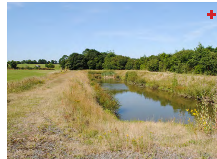
BASSIN DE RETENTION
