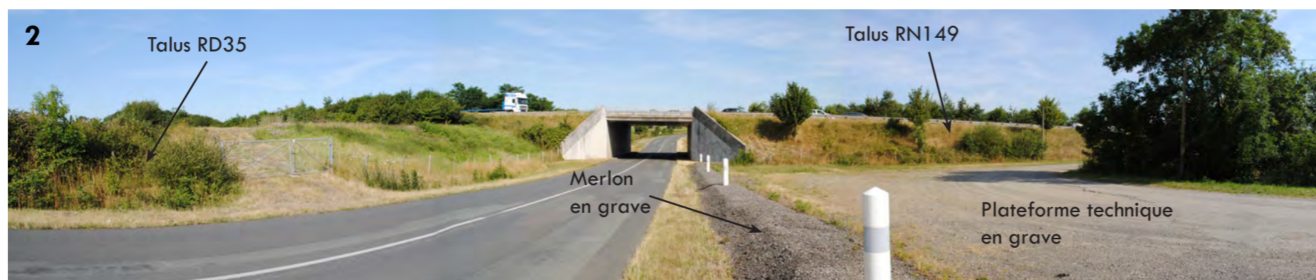
Les abords de l'ouvrage sont très techniques et peu qualifiés. Une vaste plateforme technique en grave, séparée de la voie par un merlon, s'impose aux abords de l'ouvrage. Les usages de cette plateforme sont peu perceptibles et semblent indéfinis.
