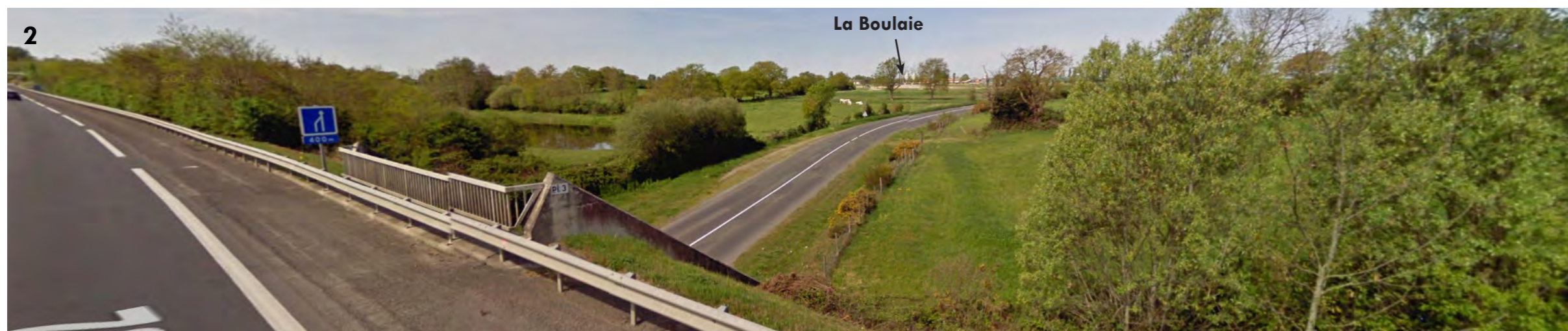
VISIBILITE SUR LA ZONE D'ETUDE DEPUIS LA RN149 - PARTIE NORD
