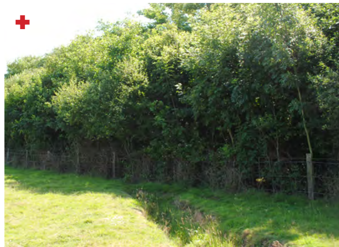
FOSSE EN PIED DE TALUS DE LA RN149
