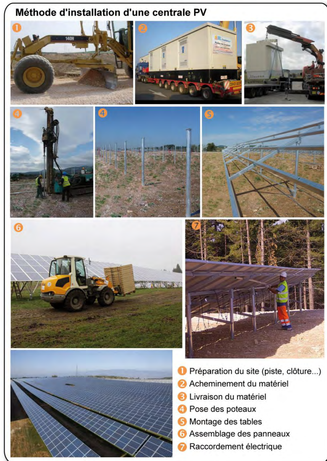
Photographie 1 : Construction d'une centrale photovoltaïque
